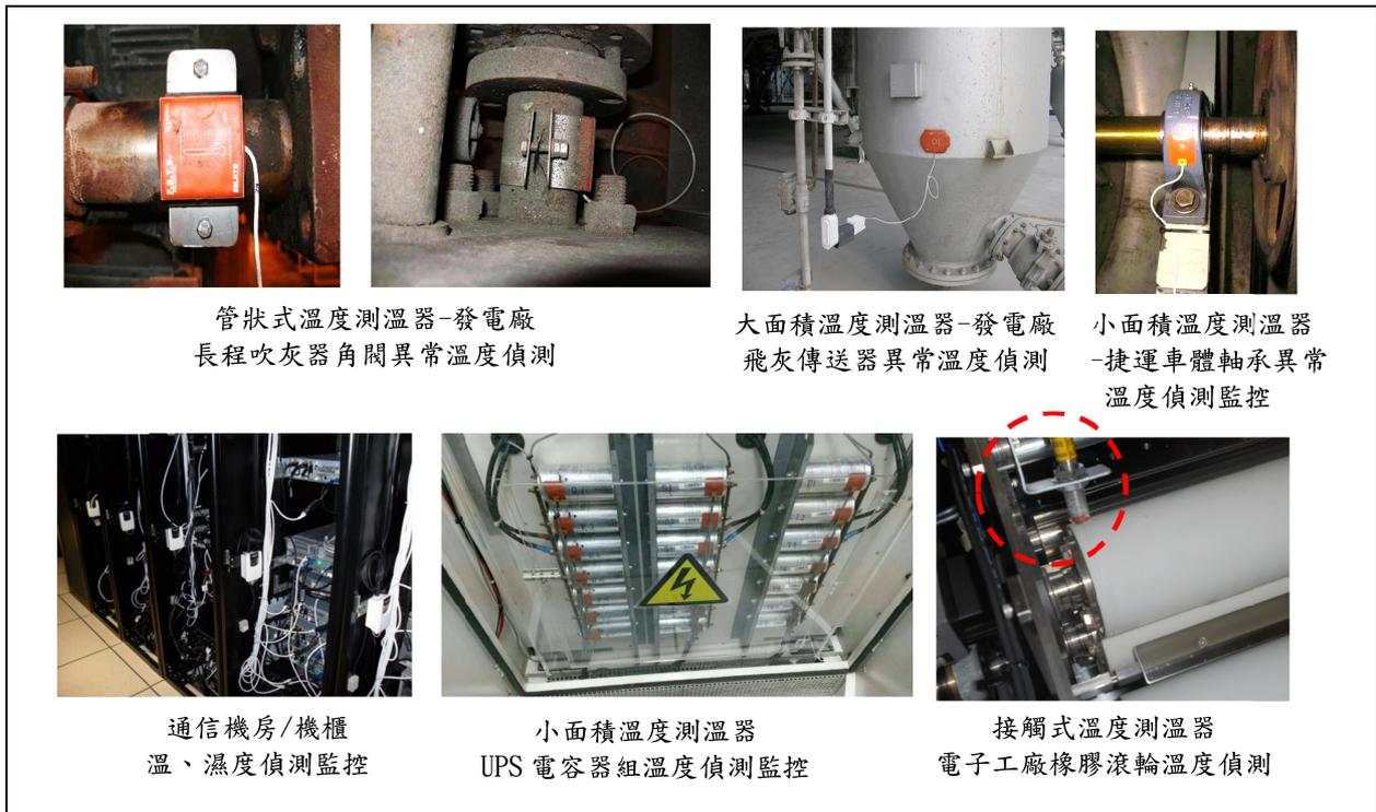
圖 12 相關機電設備溫度偵測參考圖
