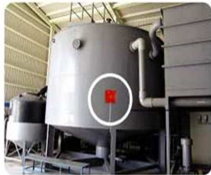
大型儲槽溫度偵測(連接範例)
